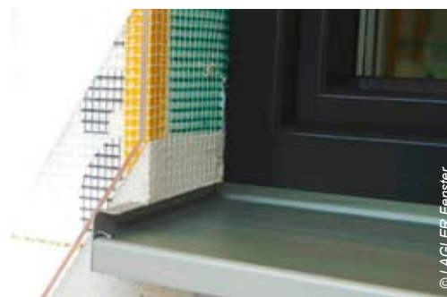
Dämmung der Fensterlaibung bei Wärmeschutzfassade
