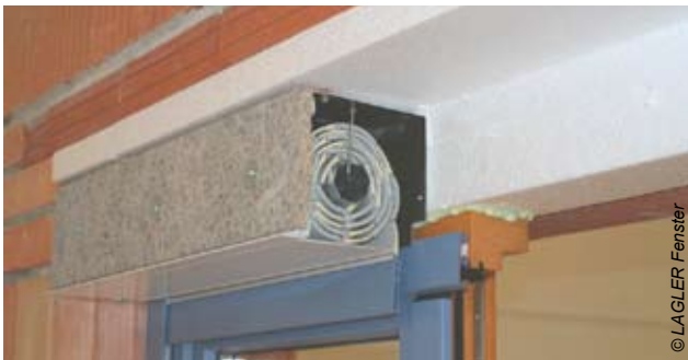
Wärmebrückenfreier Einbau eines Rollladens
