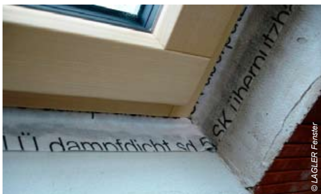
Luftdichter Einbau mit Glattstrich und Klebefolie
