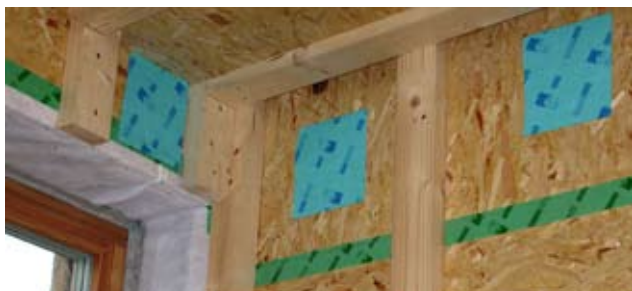
Sorgfältiges Abkleben mittels Dichtband
