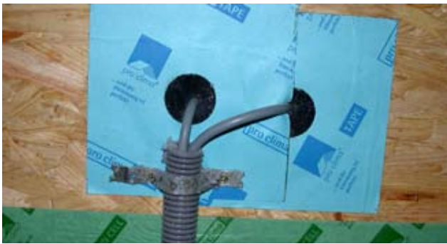
Luftdichte Rohrdurchführung
