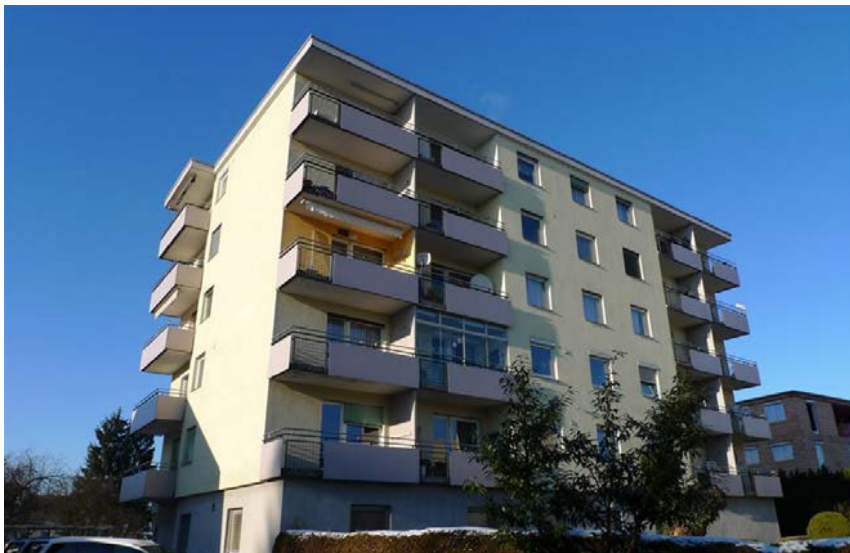
Foto: Mehrfamilienwohnhaus Bahnhofstr. 43, 6890 Lustenau mit WDVS aus Styropor (Baujahr 1966)
