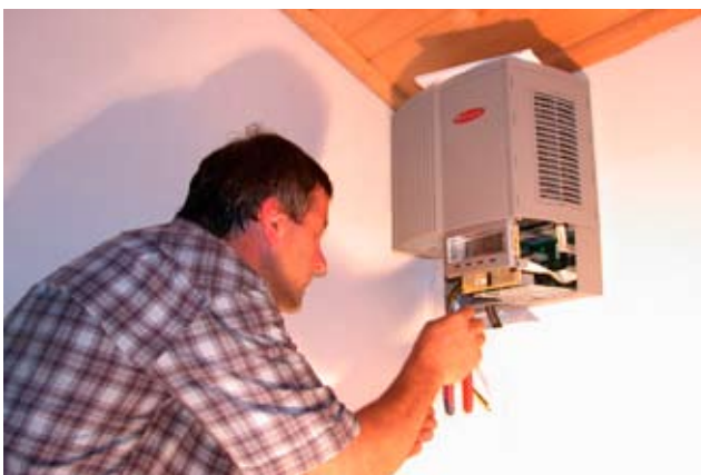
Montage Wechselrichter, Foto "die umweltberatung"
