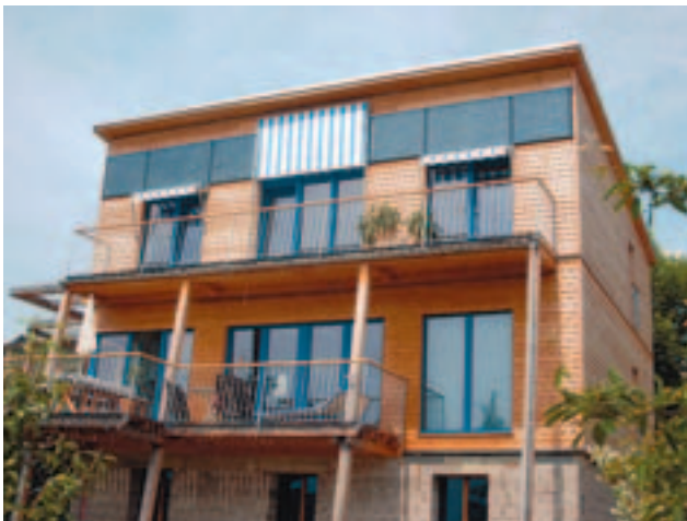
Südfassade eines Passivhauses (Quelle: DI Manfred Sonnleithner)
