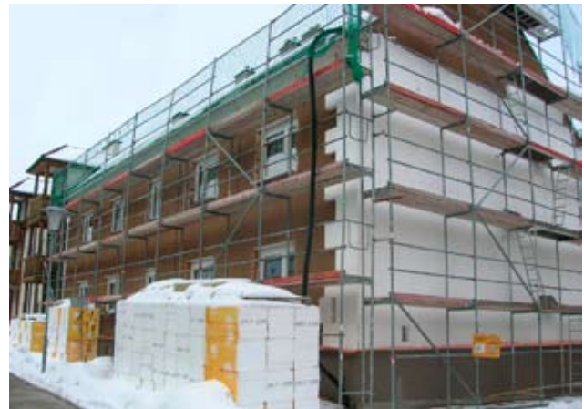
Dämmung mit Polystyrol-Hartschaum Platten (EPS)
