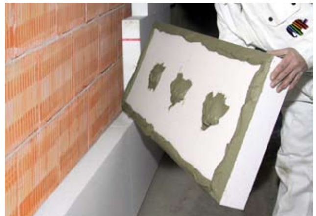
Montage mit Klebemörtel in Randwulst-Punkt-Methode Foto: Capatect
