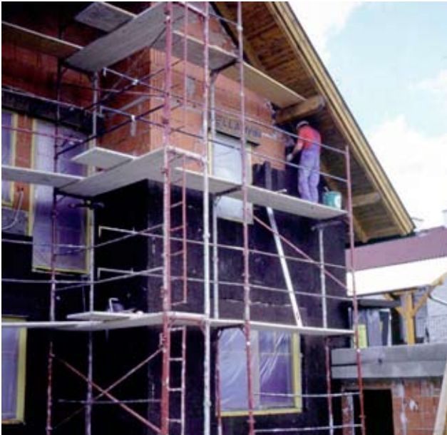
Wärmedämmung mit Kork
